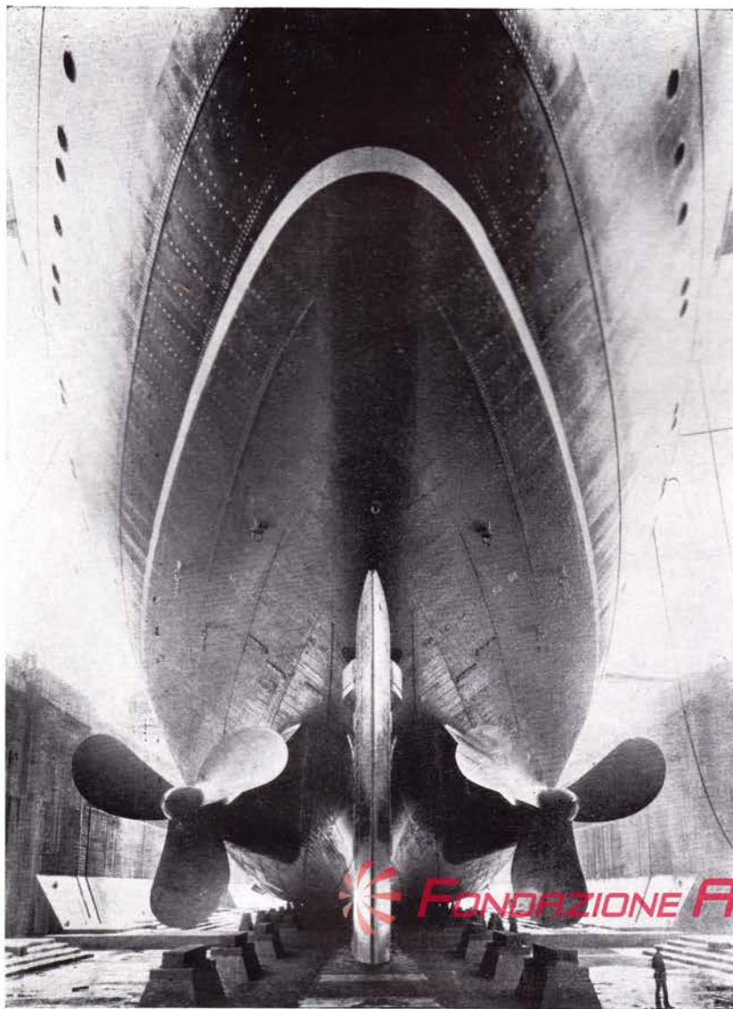
Lavori in bacino
