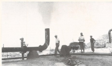
SPIAGGERI di Cetara a Ischia: tuba conduttrice del vapore naturale dell'Isola utilizzato nella centralina sperimentale della S.A.I.F.E.S. Sotto: la collina di Montecorvo, dove si trovano i pozzi dai quali vengono convogliati i solfuri di vapore. In fondo, piovola, la centrale.
