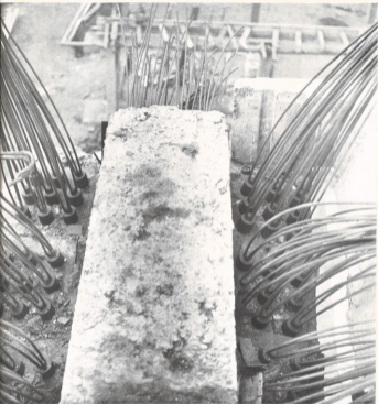
LE TESTATE della trave della fabbrica del Castellaccio con i rami fissati a tre a tre e bloccati con una spianata. Ogni cavo è fissato da una forza di 10.000 Kg al centimetro quadrato.
