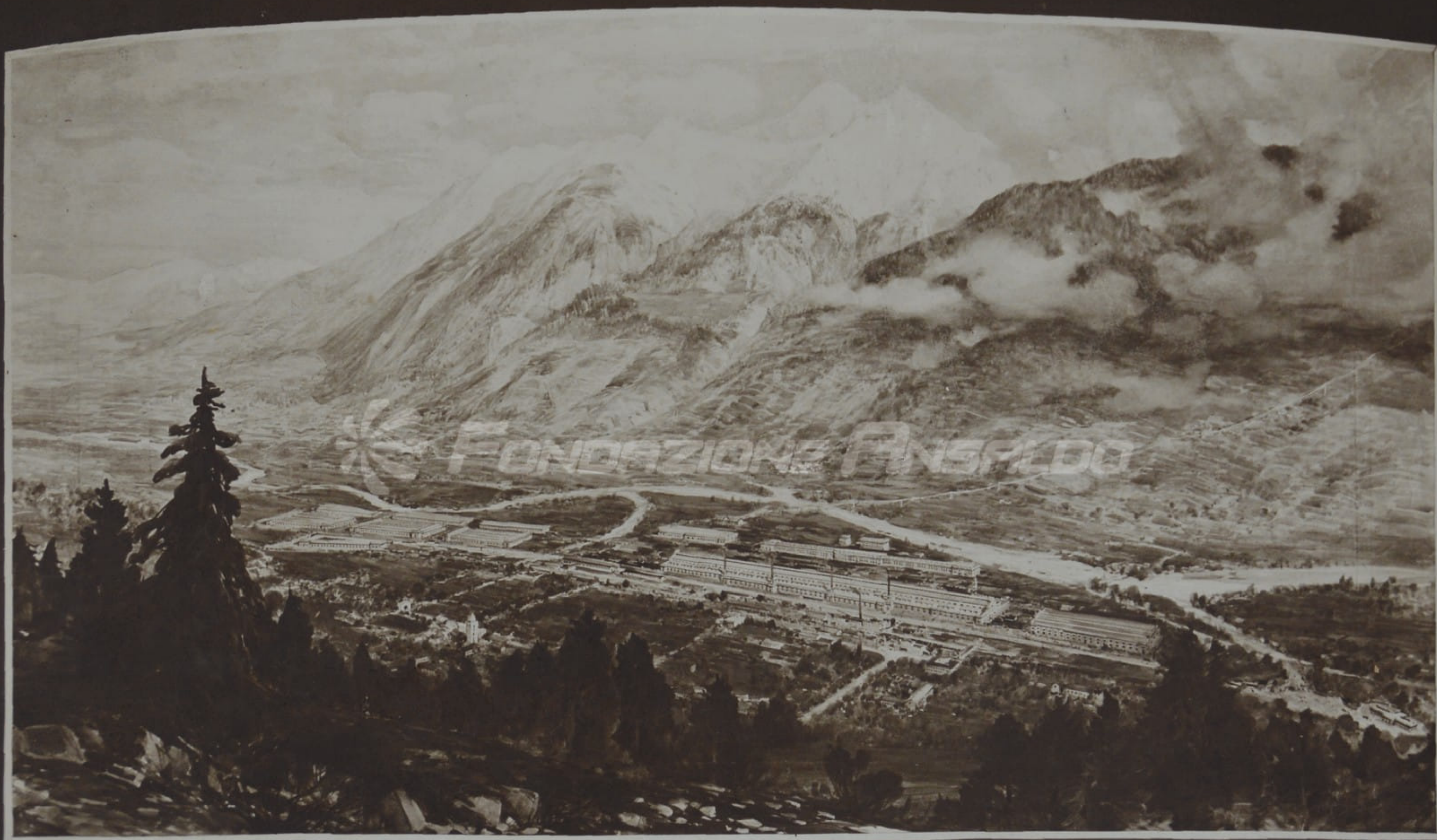
S.A.I. GIO ANSALDO & C I GRANDI STABILIMENTI ELETTRICO-SIDERURGICI DI AOSTA -
