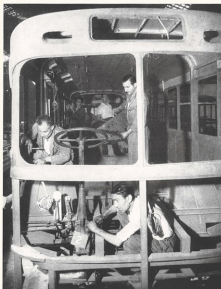
MONTAGGIO delle apparecchiature di un automoto nel reparto montaggio dell'ENAM.
