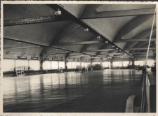
- Sala a tralicci
