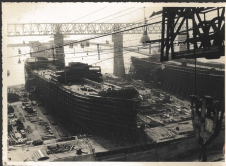
- La Volpe, in costruzione.
