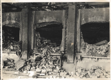
- I forni Martin lasciati crollare dalla direzione prima di abbandonare lo stabilimento.
