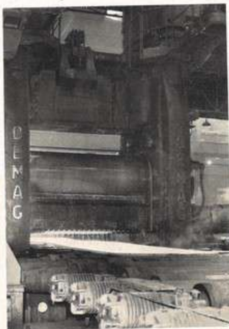
Nella pagina accanto: il lingotto proveniente dal forno a pozzo viene depositato sul carrello ribaltatore.
