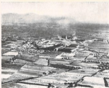
VEDUTA aerea della stabilimento di Dalmine (Bergamo).
