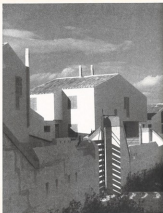
UNA STRADA della Martella. Le case, come si vede, non hanno quel tipo di grande estrema che estende le infiltrazioni d'acqua.
